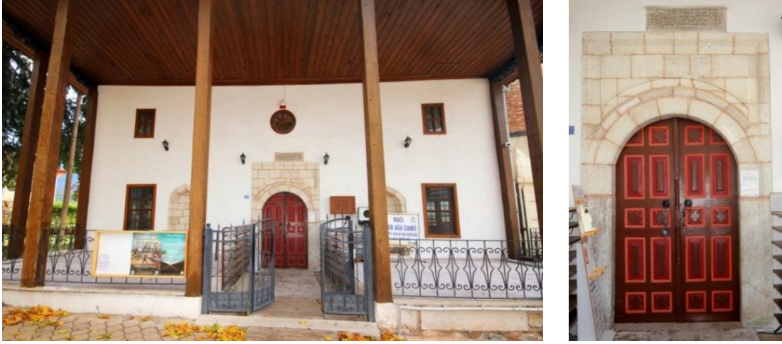
Şekil 6-7. Kuzey Cephe ile Harim Giriş Kapısı
