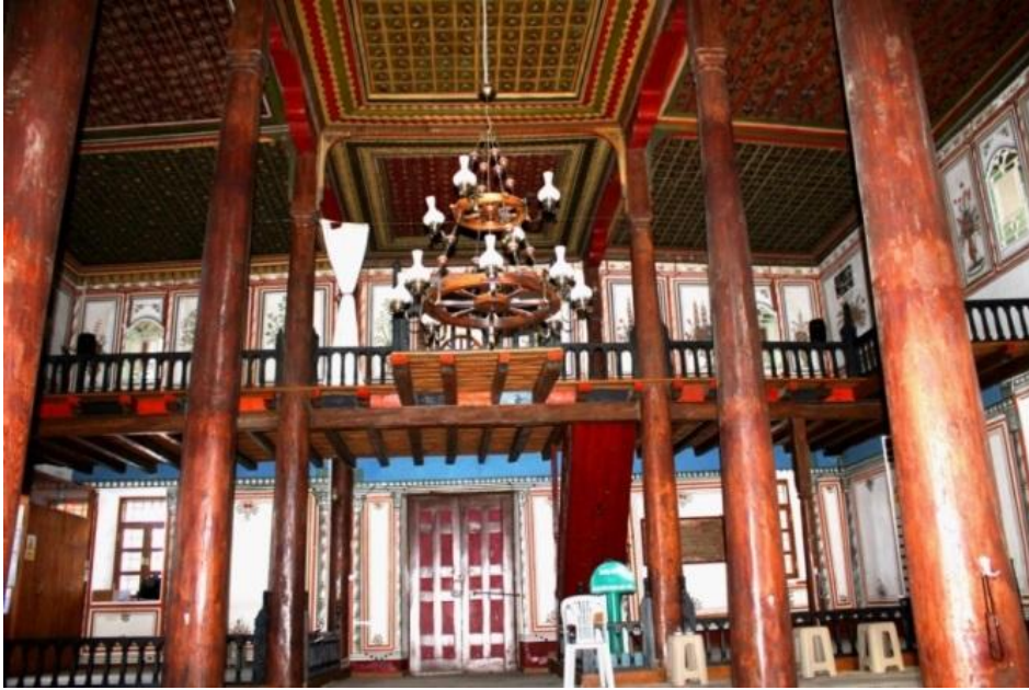
Şekil 10. Harim Mekânı Kuzey Duvarı
